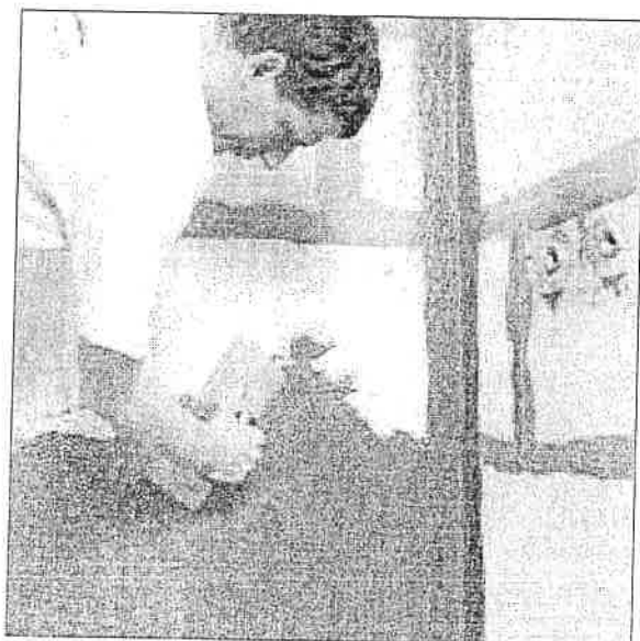
For at være sikker på at lovens krav om 1 mm lagtykkelse er overholdt, bør man påføre pastaen med en 4 mm tandspartel.
