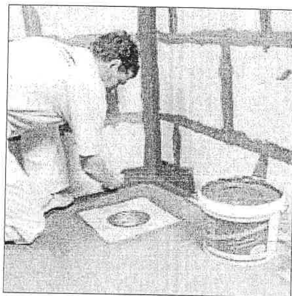
Påføringen af LIP Vandtætningspasta mellem gulv/væg, væghjørner omkring gulvaflob samt rorgennemføringer foretages med pensel.
