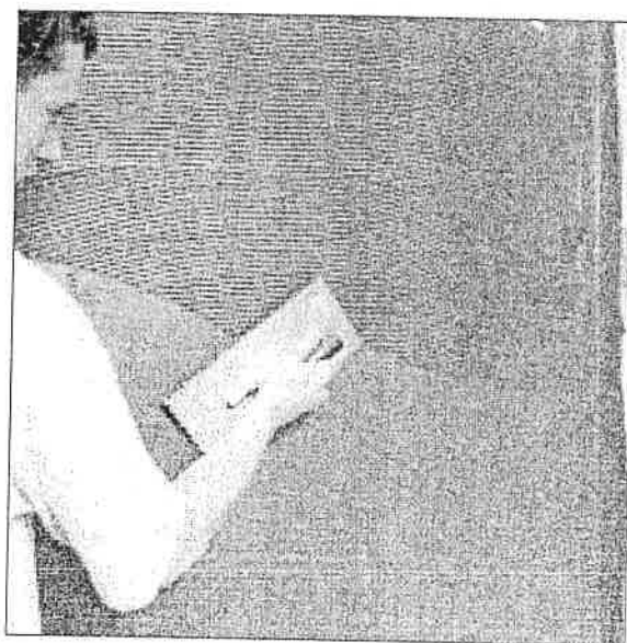
Når påføringen er foretaget, vender man spartlen og glatter overfladen.
