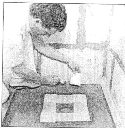
Montering af armeringsvæv med LIP Vandtætningsbinder
